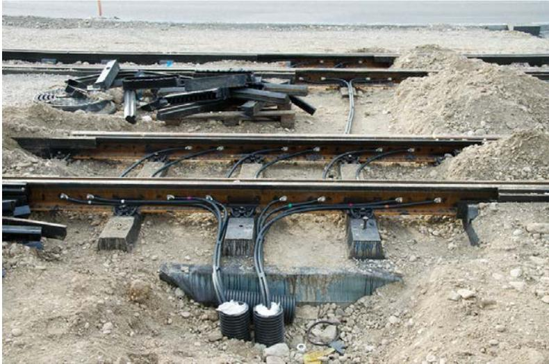
**Abb. 33 Rückleiter bei der Linzer Straßenbahn im Bereich der Trauner Kreuzung. Aufnahme während der Bauarbeiten am 03.10.2015**
