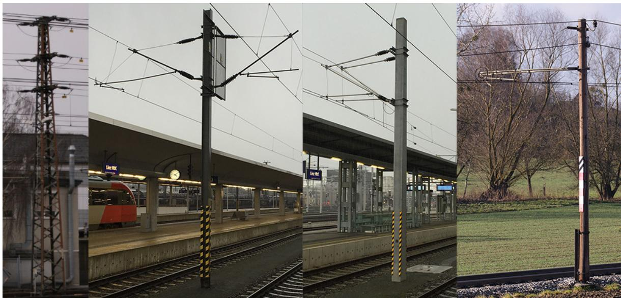
Abb. 29 Turmmast, Stahlmast, Betonmast und Holzmast
