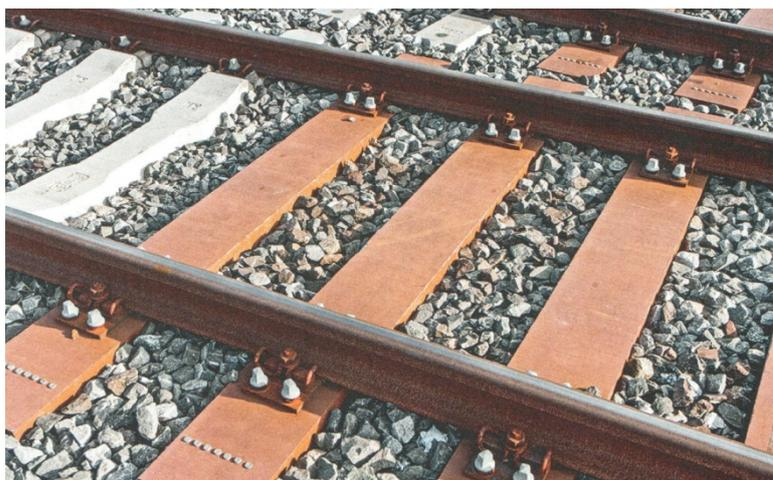
Abb. 27 Kunststoffschwelle neben Stahlbetonschwelle
