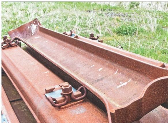
**Abb. 25** Aufgearbeitete Stahlschwellen. Die aufgeschweißten Schienenbefestigungspunkte sind gut zu erkennen
