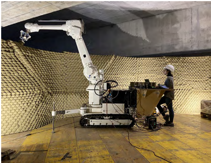
Abb. 196: Prozess Lehmbau mit Robotics
