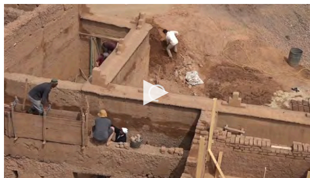
Abb. 185: Lehmbaustelle in Marokko
