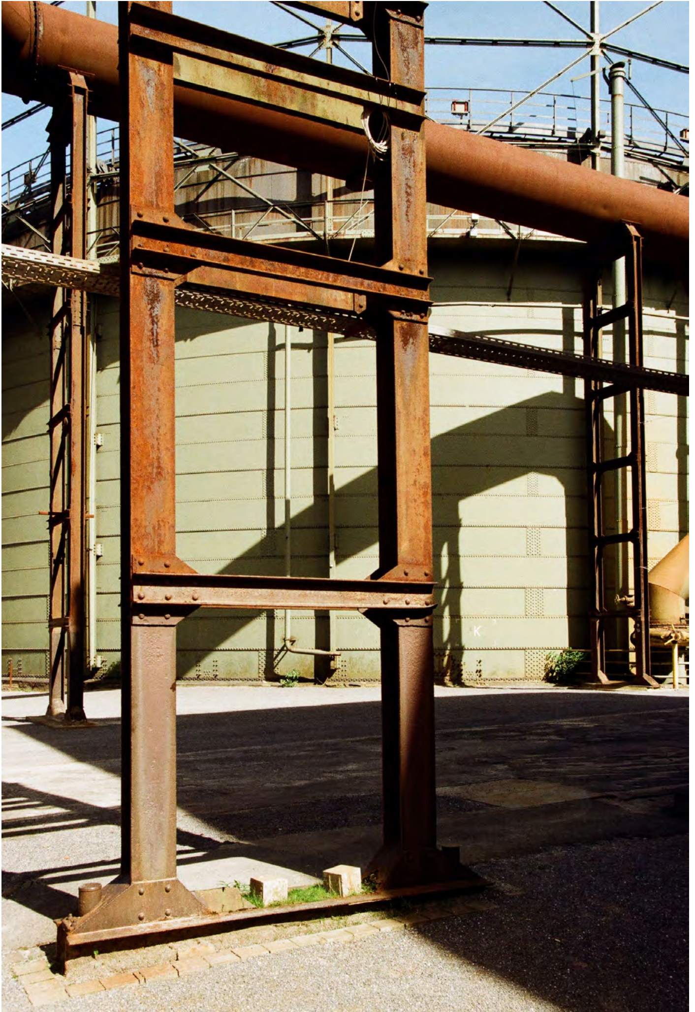
Abb. 58: Stahlgerüst im Landschaftspark Duisburg
