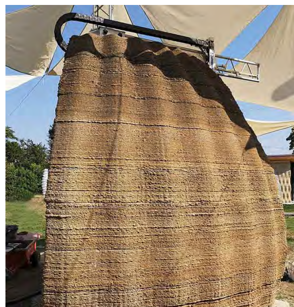
Abb. 215: 3D Druck mit Flüssiglehm
