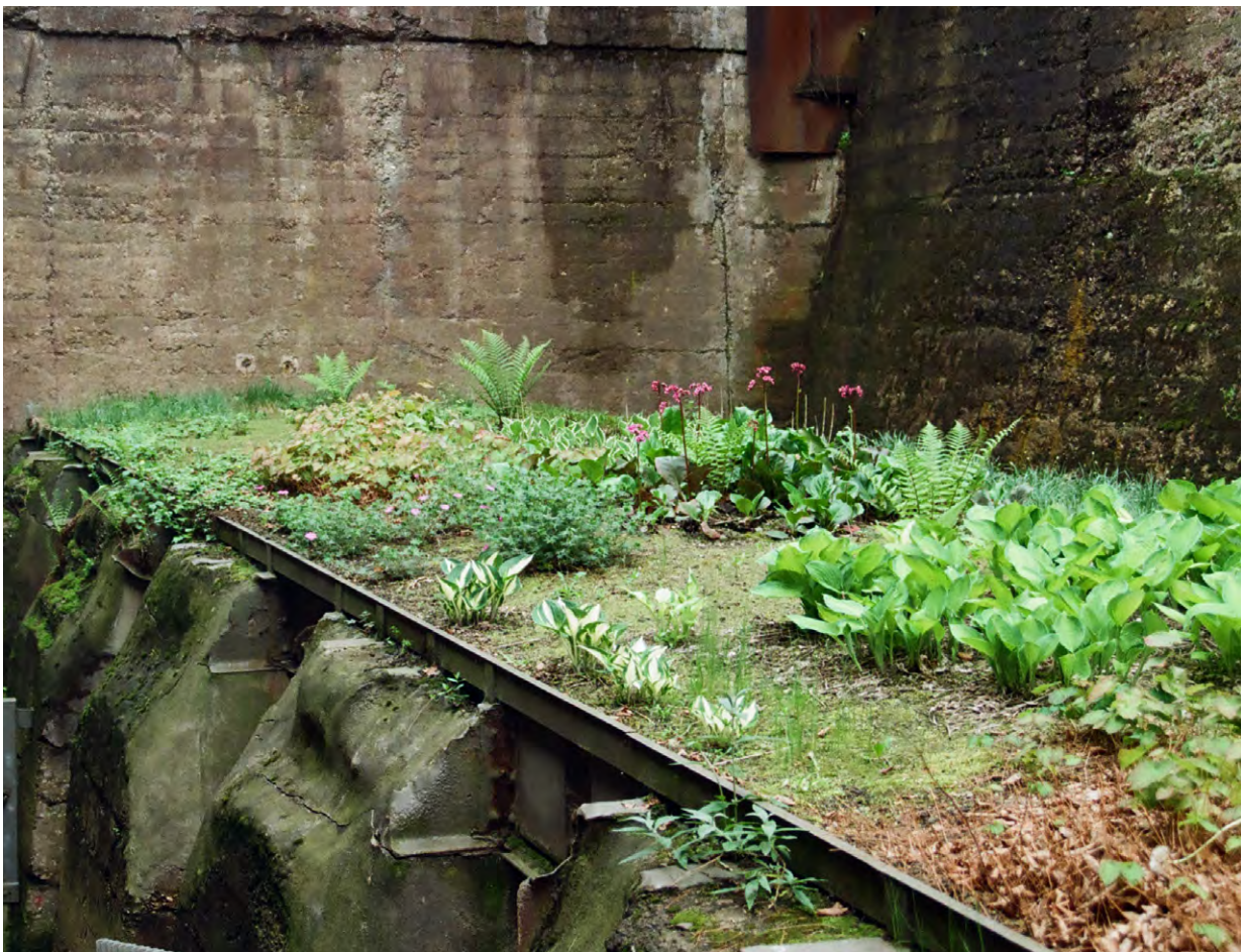
Abb. 77: Gründach im Bunkergarten
