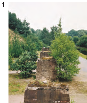
Abb. 93: Auflager Gleisbrücke
