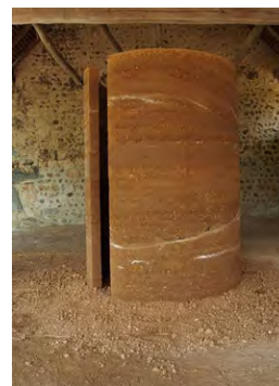
Abb. 160: Raum aus Lehm
