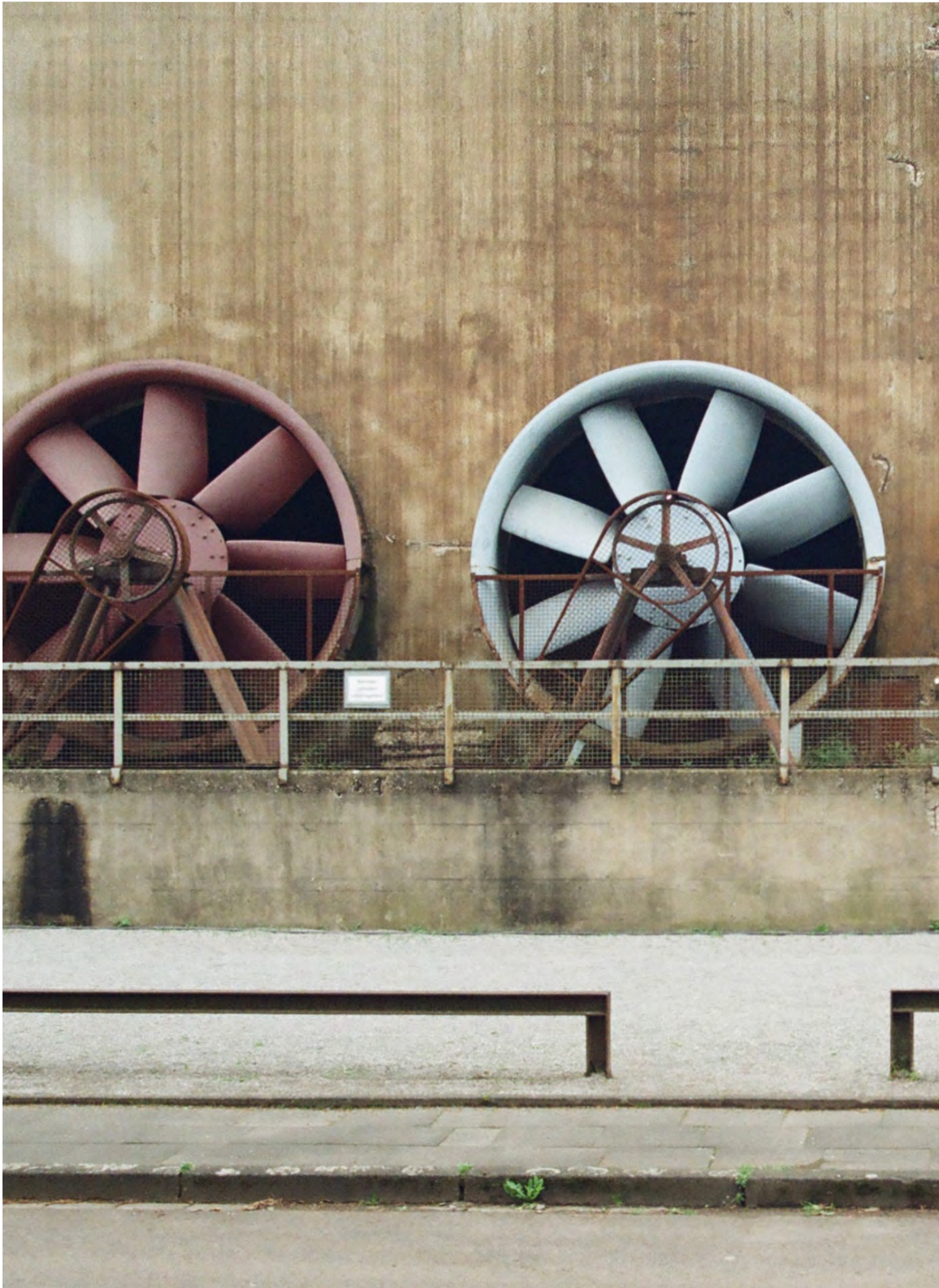
Abb. 73: Kühlwerk Landschaftspark Duisburg
