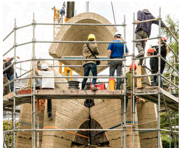
Abb. 207: Bau des Pavillon der ETH Zürich
