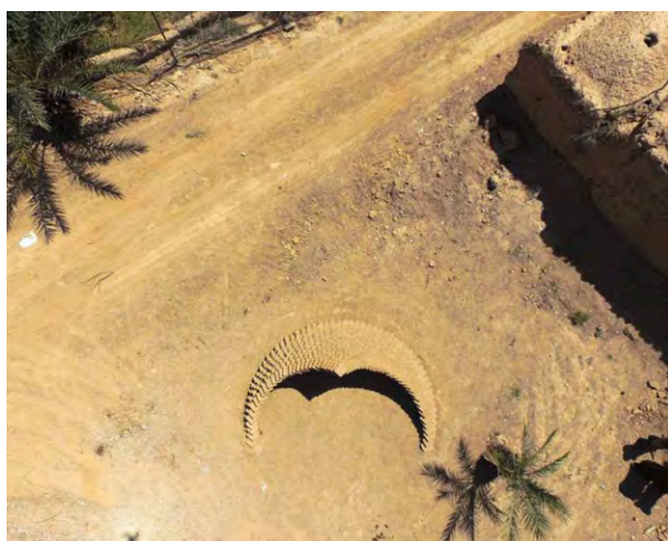
Abb. 211: Geformte Lehmsteinwand
