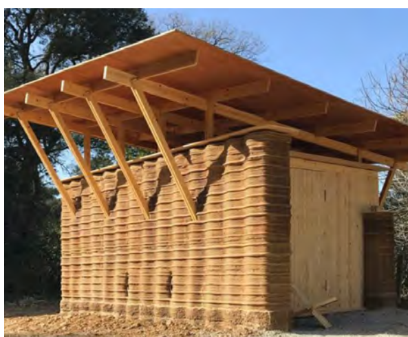
Abb. 214: Pavillon mit 3D Druck Stampflehmwand
