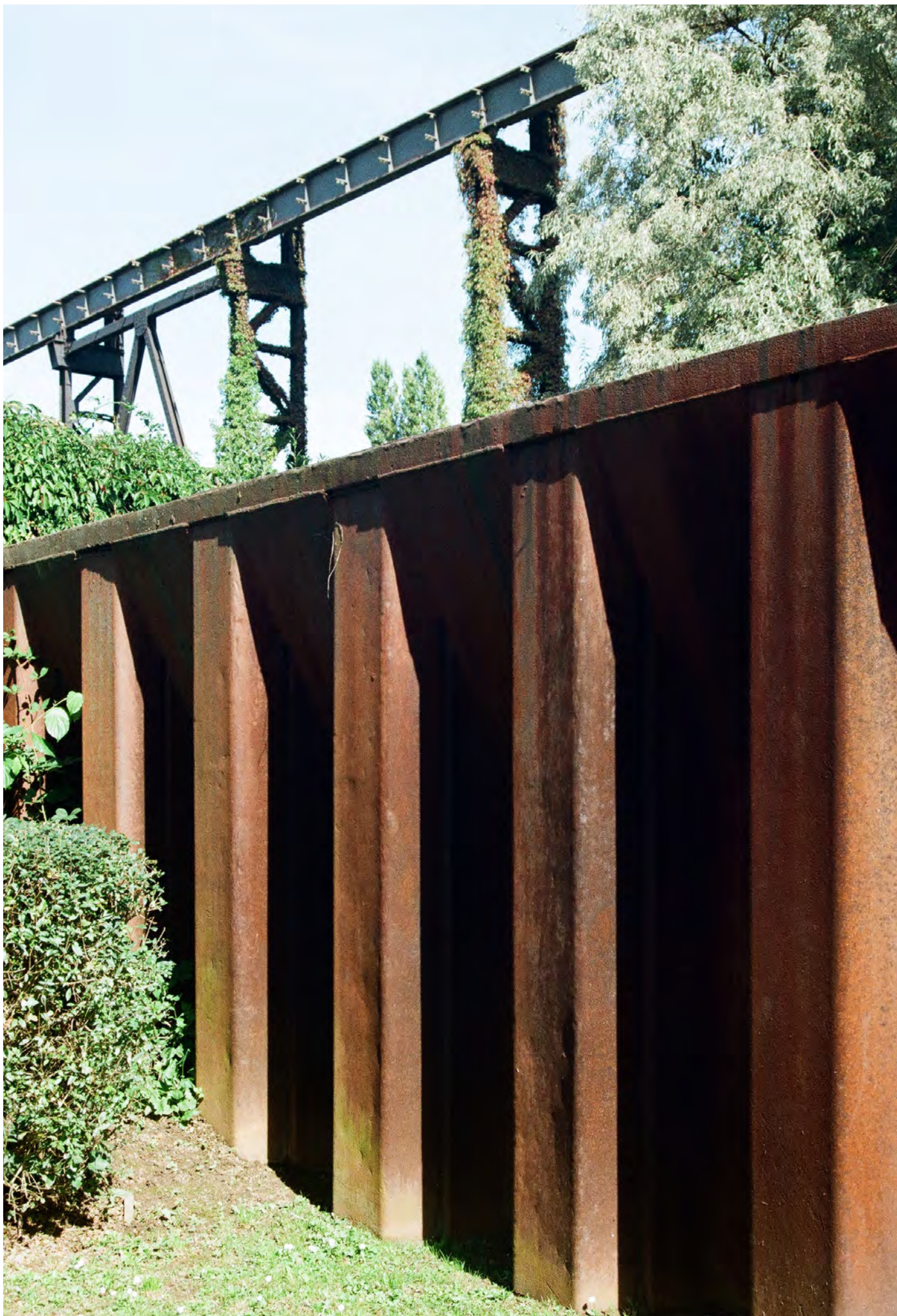
Abb. 120: Spundwand und Kranbahn
