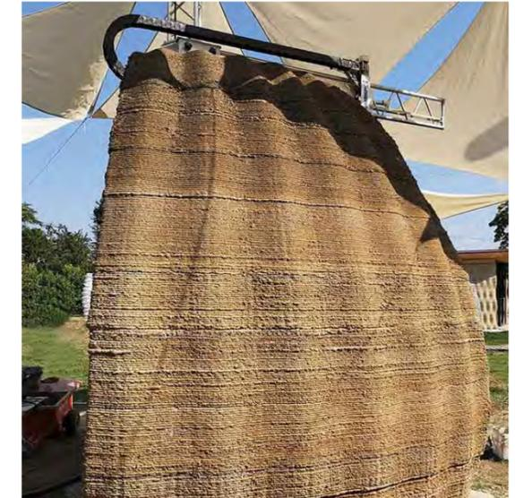
Abb. 215: 3D Druck mit Flüssiglehm
