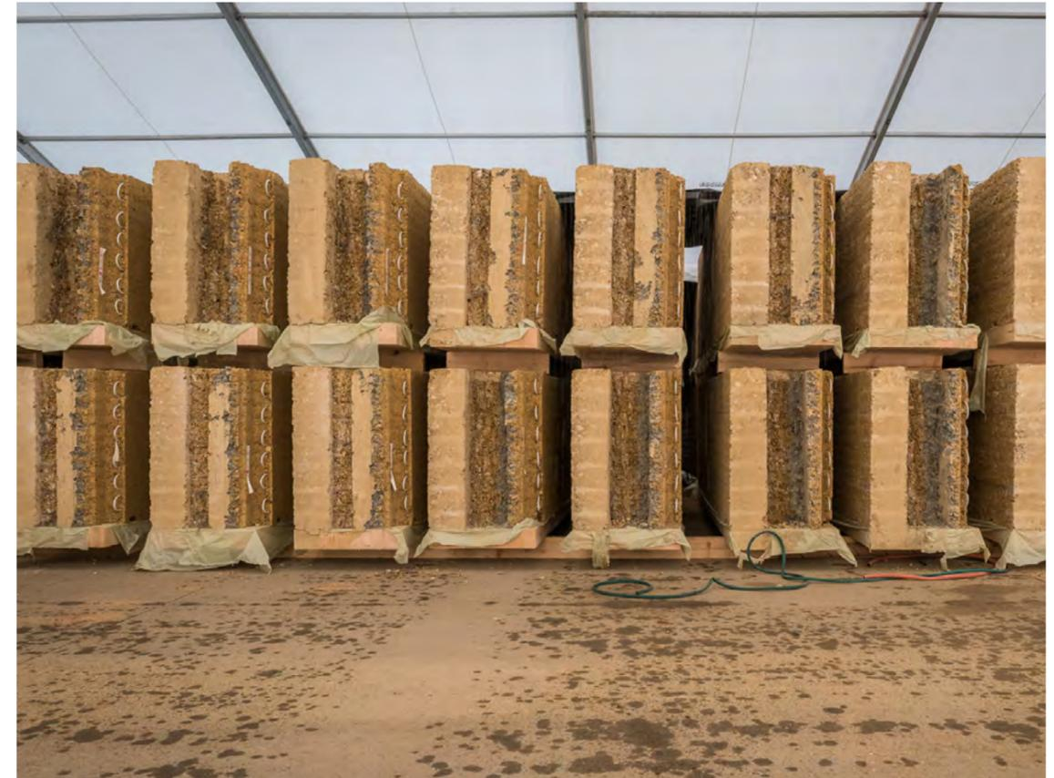
Abb. 14: Lagerung der vorgefertigten Stampflehmelemente
