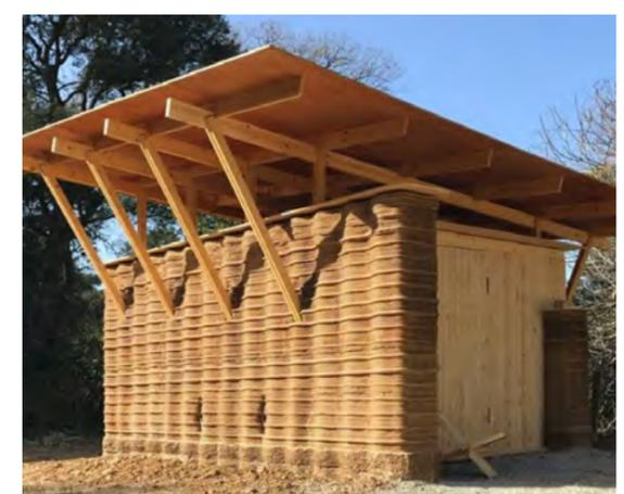
Abb. 214: Pavillon mit 3D Druck Stampflehmwand
