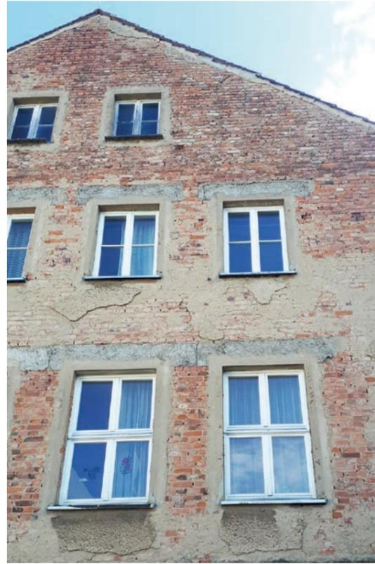
Abb. 49: Konstruktion der Außenwände: Ziegelmauerwerk mit Stahlbetonstützen, Foto: Baugruppe Festland
