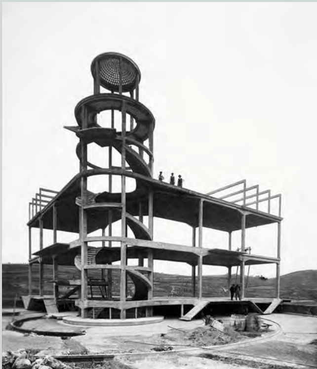
Abb. 125 | Ein sich drehendes Haus, das dem Lauf der Sonne zu folgt. Villa Girasole, Verona (IT), Angelo Invernizzi & Ettore Fagioli, 1935. Abb. 126 | Villa Girasole im Rohbau, Verona, 1932.
