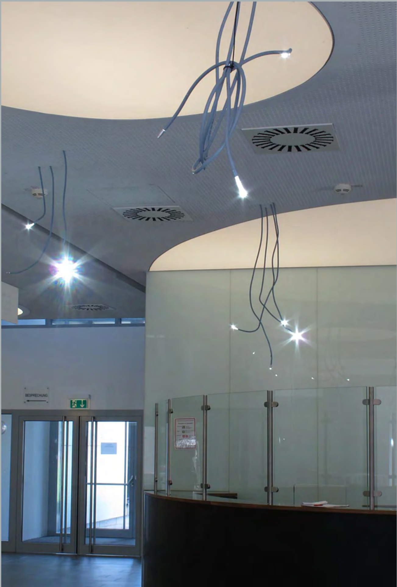
Abb. 226 | Eine direkte Sonnenlichtleitung aus Glasfaserkabeln im Haus der Forschung, Wien (AT). Angelo Stagno & Andrea van der Straeten, 2006, 0-24 Licht .
